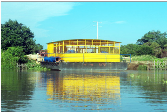
Captación de Sabanagrande vista desde aguas arriba.
