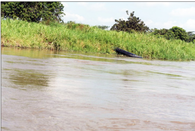
Tubería de aducción de agua cruda.
