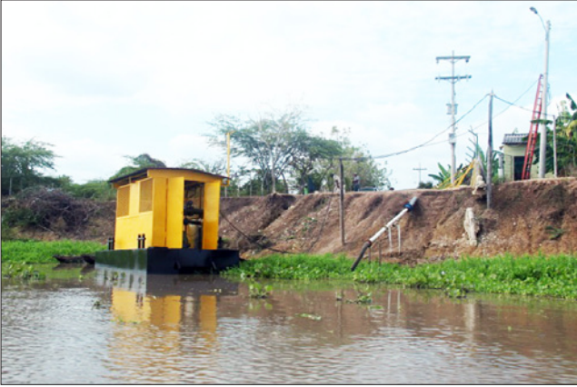
Vista desde aguas abajo de la captación de Puerto Giraldo.
