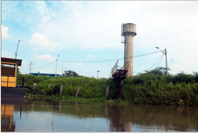
Vista desde aguas abajo de la captación, aducción y tanque de Santa Lucía.
