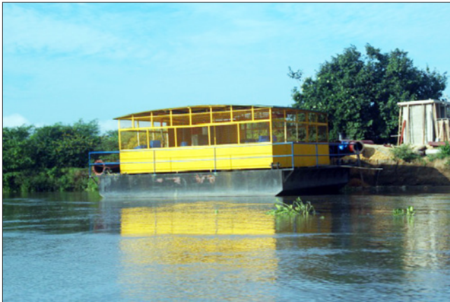
Captación de Sabanagrande vista desde aguas abajo.
