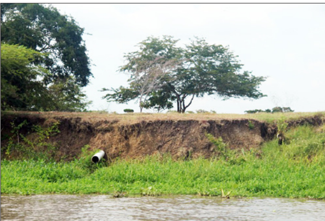
Vertimiento de agua sobre el río, aguas abajo de la captación de Puerto Giraldo.
