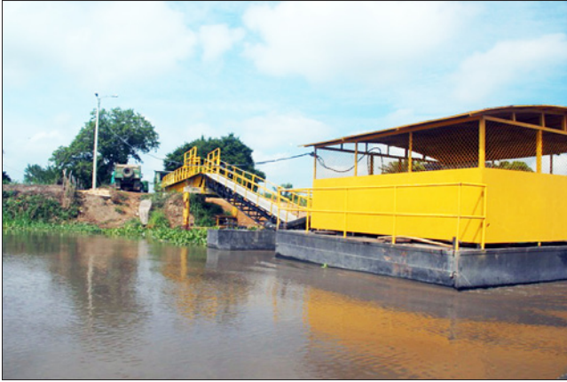
Vista desde aguas arriba de la captación de Suan.
