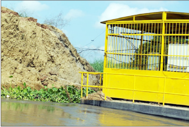
Vista desde aguas arriba de la captación de Campo de la Cruz.
