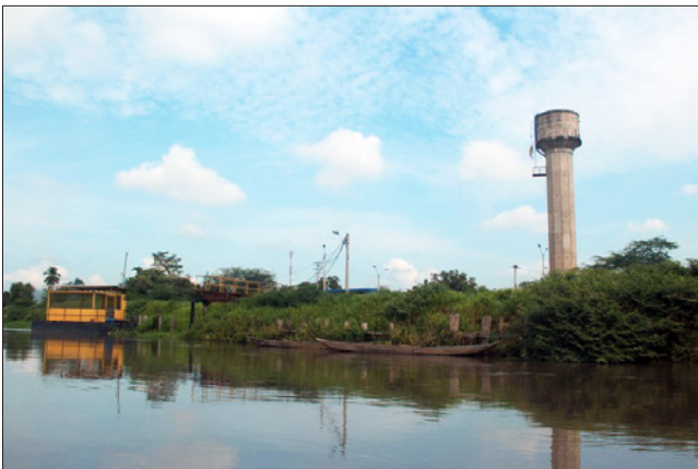
Vista desde aguas abajo de la captación de Santa Lucía.
