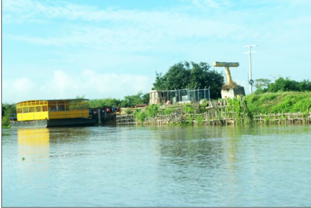
Captación de Sabanagrande vista desde aguas abajo.
