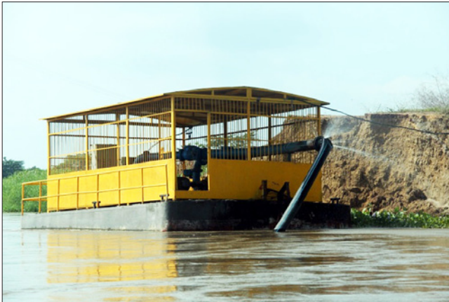
Vista desde aguas debajo de la captación de Campo de la Cruz.
