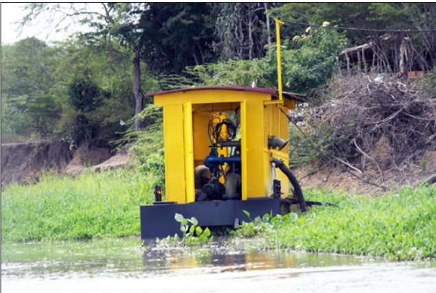
Interior de la captación de Puerto Giraldo.
