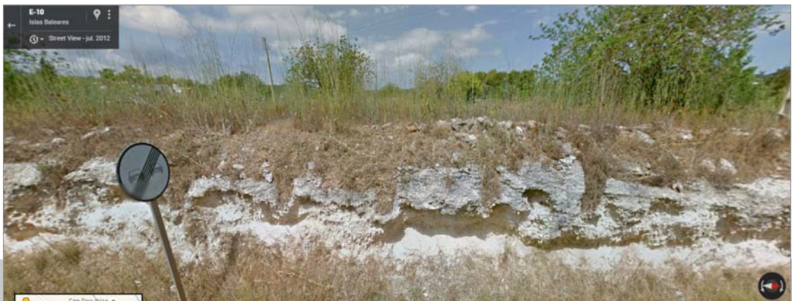
Figura 1. Vista extraída del Google Street View del talud de la carretera previo al inicio de las obras en una de las dos zonas consideradas como yacimiento arqueológico y que la dirección de obra consideró con ausencia de restos. Se observan claramente los recortes en la roca
