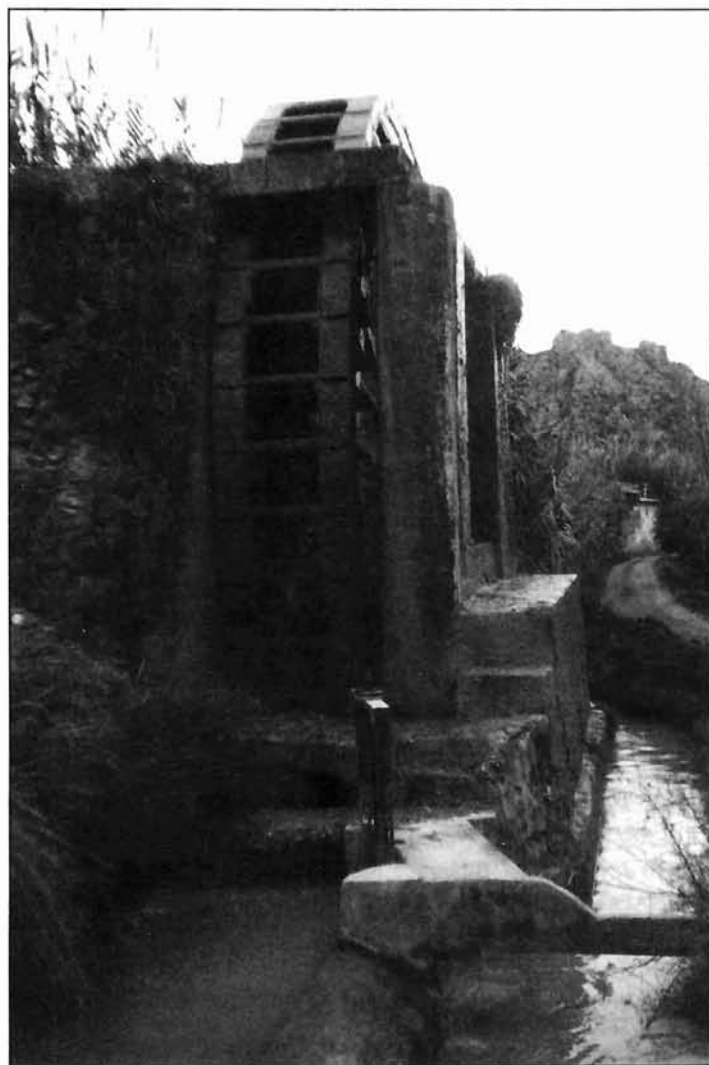
FIGURA 15. Panorámica general del sistema hidráulico: aparatoacequia. (Rueda de corriente elevadora de agua y cauce que la contiene).
