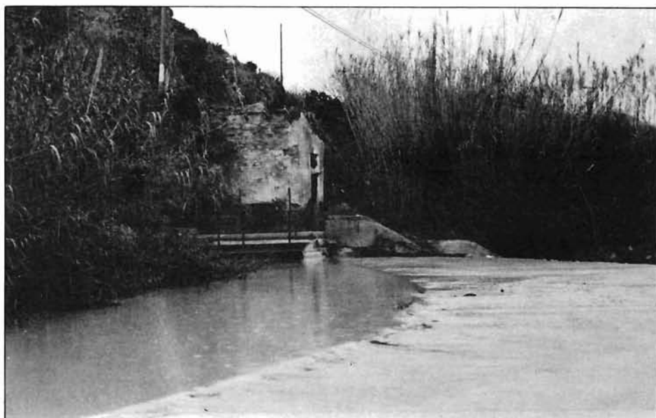
FIGURA 9. Azud y toma de la Acequia Principal. Paraje «El Menjú».
