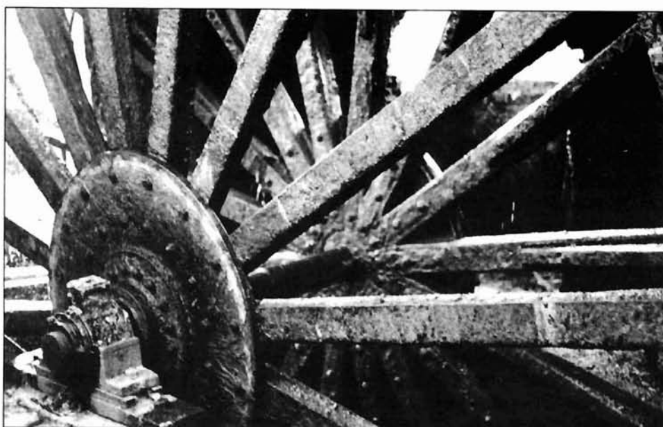
FIGURA 7. Elementos constitutivos de la noria. Se aprecia el eje, los cojinetes, los platos metálicos y los radios.
