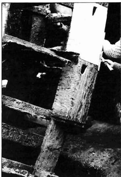
FIGURA 8. Elementos constitutivos de la noria. Detalle de la corona formada por cercha y cangilones.
