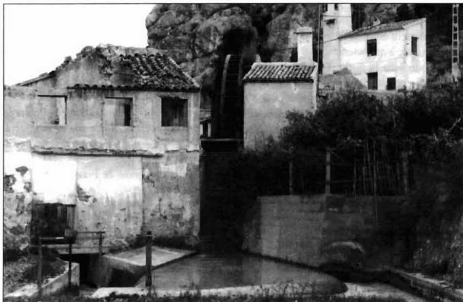
FIGURA 14. Partidor, aguas abajo de la Noria Grande.
