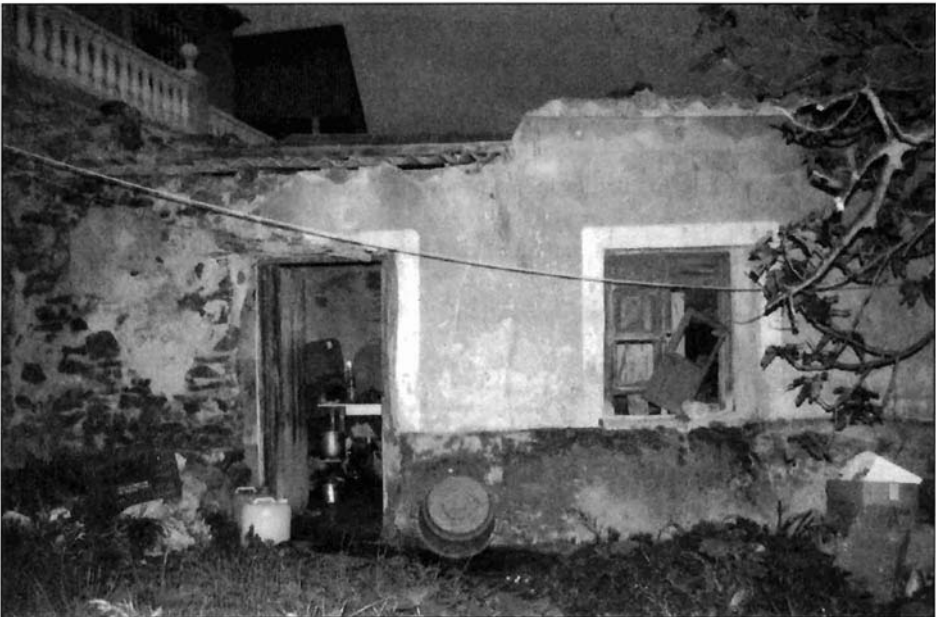
Aspecto exterior de dos viviendas
