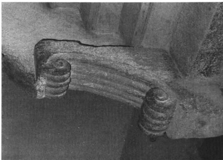
6. Ménsula-machón de la escalera.
