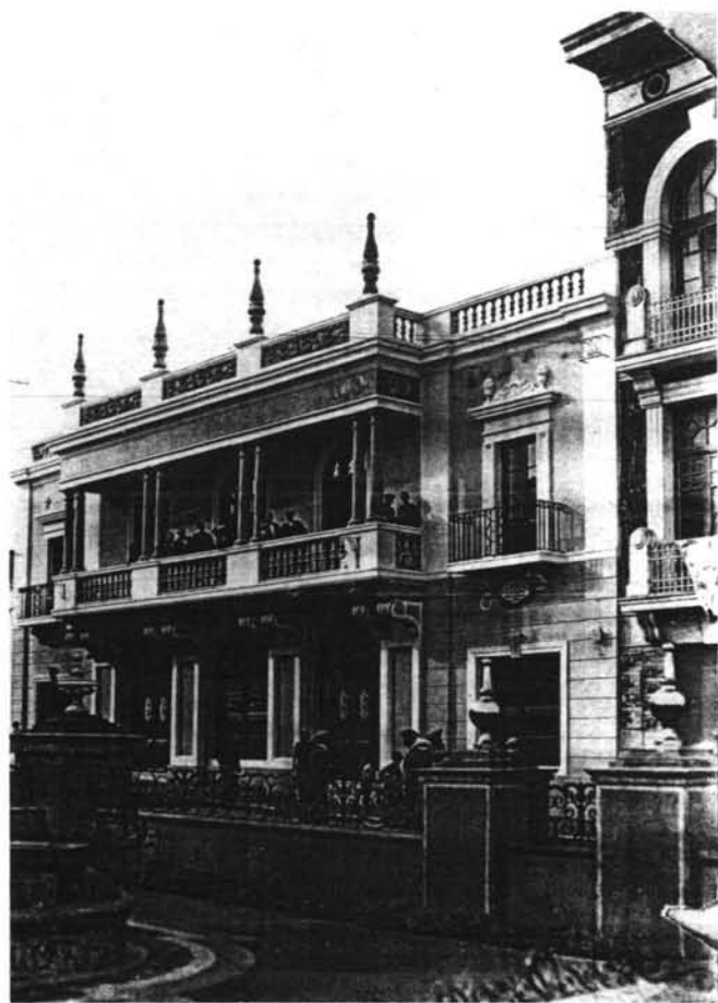
Fig. 11. El obrero extremeño antes de la última reforma.
