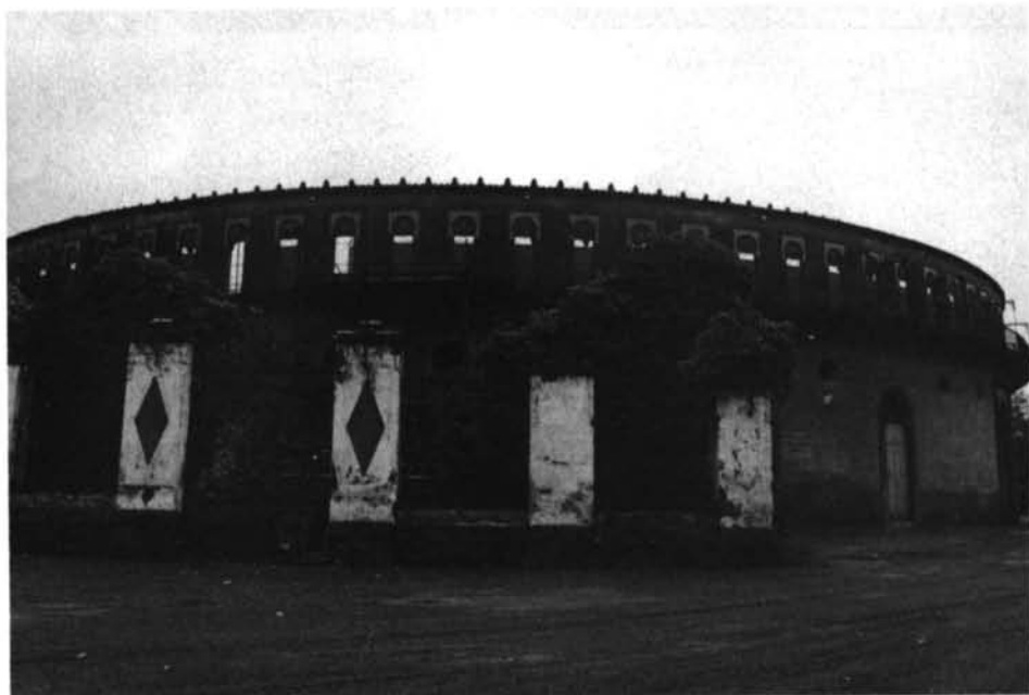
Fig. 5. Plaza de toros. Vista exterior.
