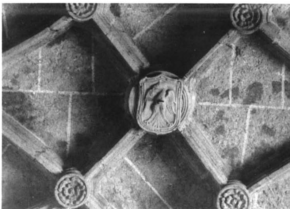
Fig. 11. Bóveda de la sacristía (detalle).
