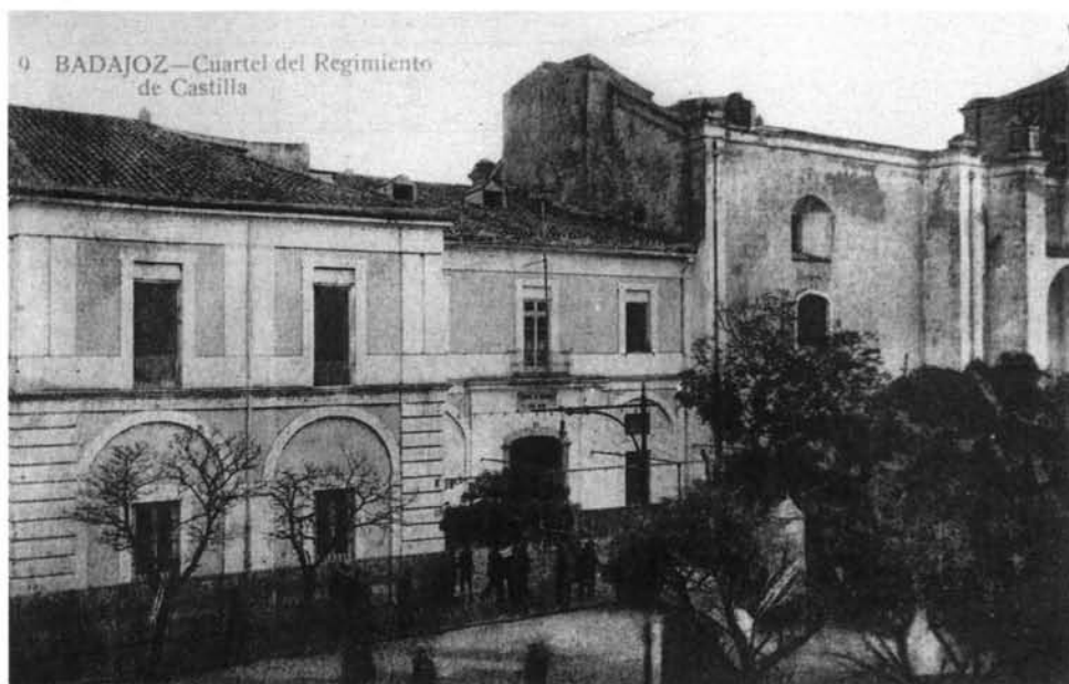
FIG. 10. Cuartel de San Francisco o del Regimiento de Castilla, fachada a la plaza de Minayo, principios de siglo.
