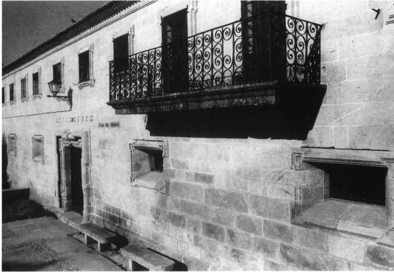
FIG. 6. Convento de San Agustín en Puentedeume (La Coruña).
