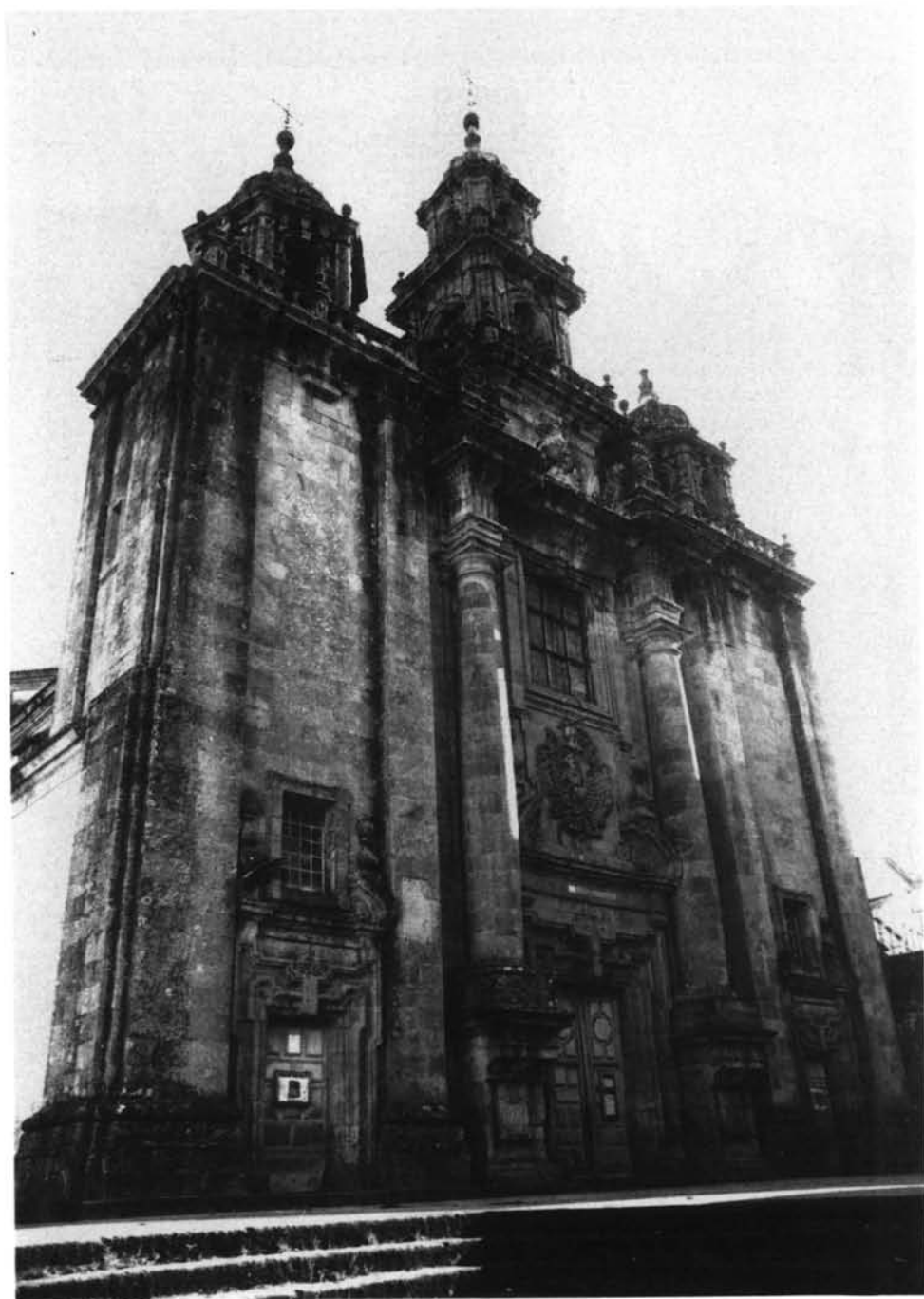
FIG. 4. Vista general de la fachada de la iglesia parroquial de Puñtendeume (La Coruña).
