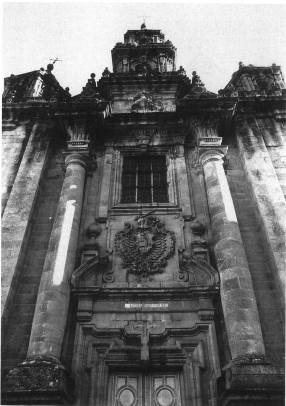
FIG. 5. Fachada principal de la iglesia parroquial de Puente deume (La Coruña).
