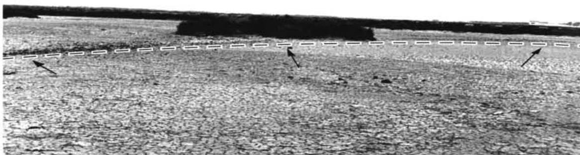
Fig. 4. Huella dejada por un antiguo muro de contención de salina (Camposoto: San Fernando, Cádiz). En el centro (conformando una isleta), la presencia de materiales cerámicos y constructivos de mayor porte ha permitido la mejor conservación de la estructura.
