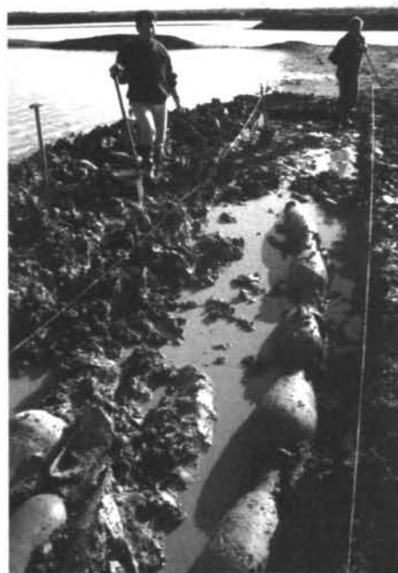
Fig. 5. Parte de un muro de contención del interior de una salina construido con ánforas, piedras y postes de madera clavados en el fango de la marisma romana.
