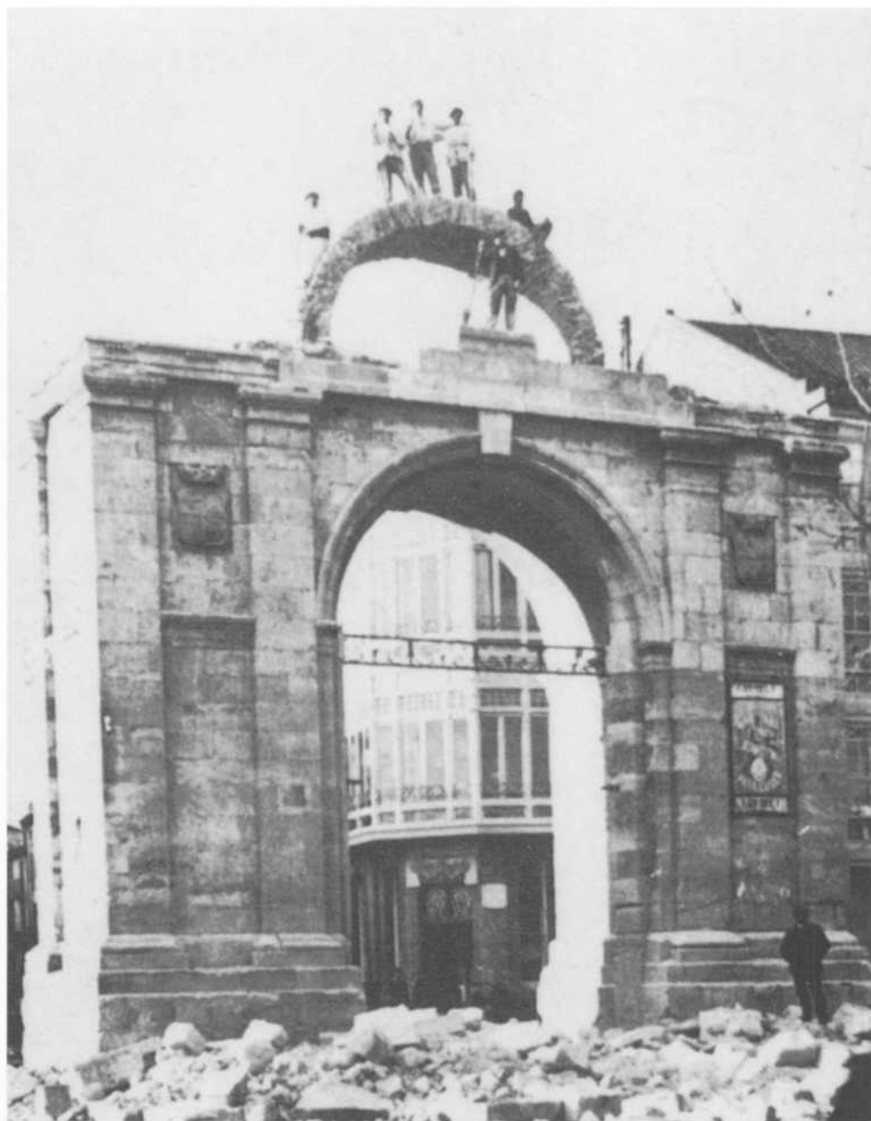
En marzo de 1909 se consumó la demolición. Habían triunfado los tecnócratas de la época y los intereses inmobiliarios.
