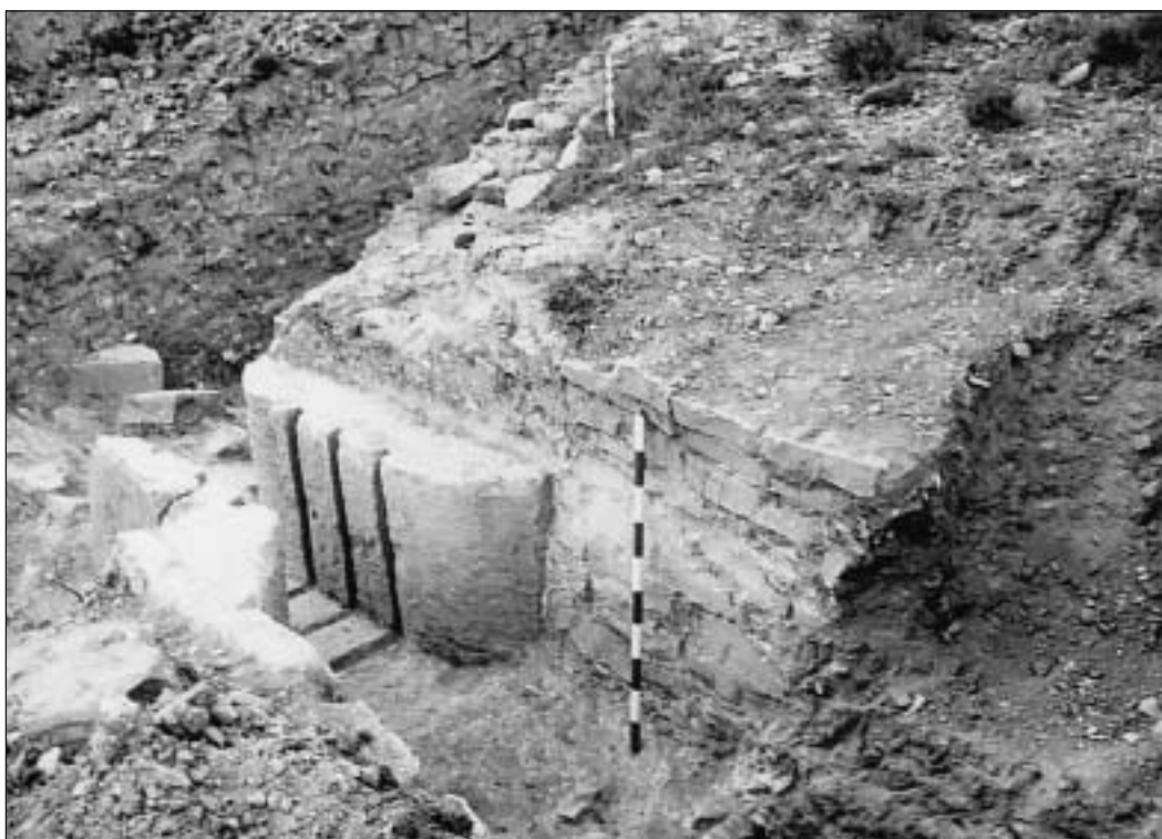
Lámina 4. Detalle del aliviadero
