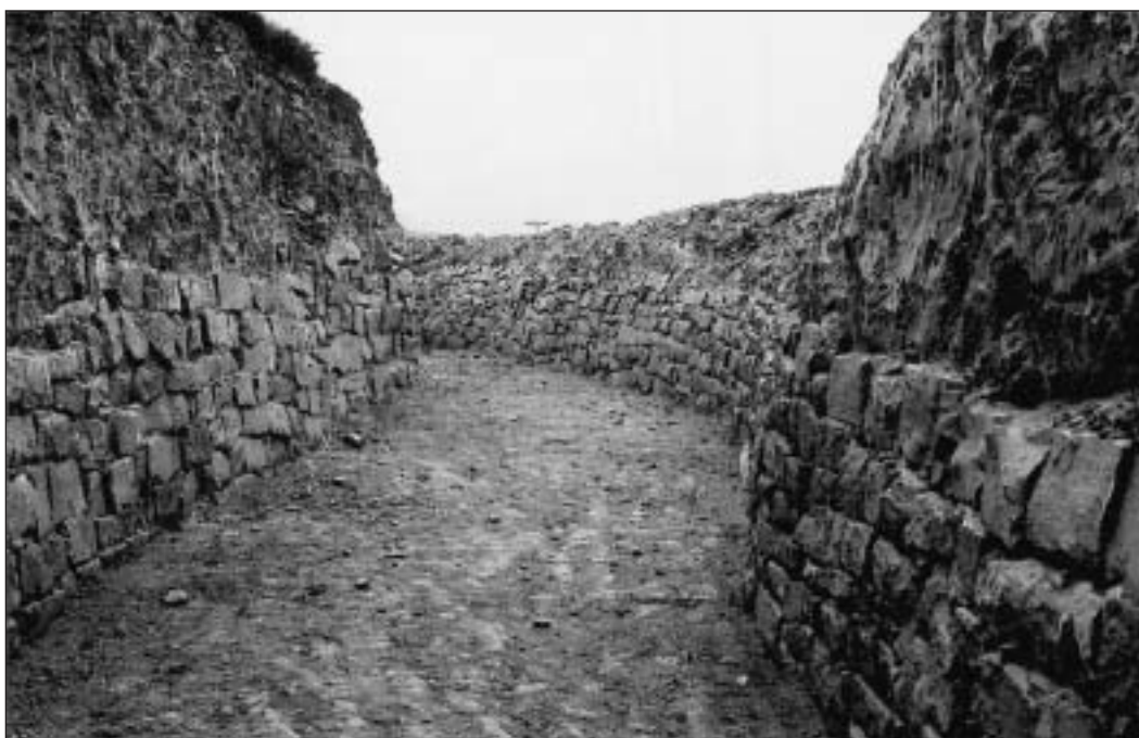
Lámina 6. Aspecto de la canalización. Trazado y modo de ejecución
