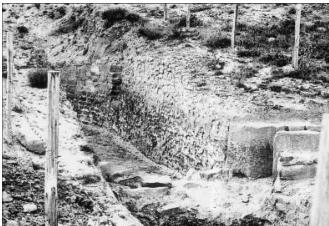
Lámina 5. Vistas de la canalización en la zona del aliviadero
