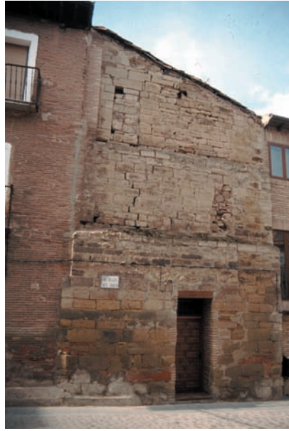
Lám. 6. Restos de la Puerta de Nuestra Señora (en la actual plaza del Arco).
