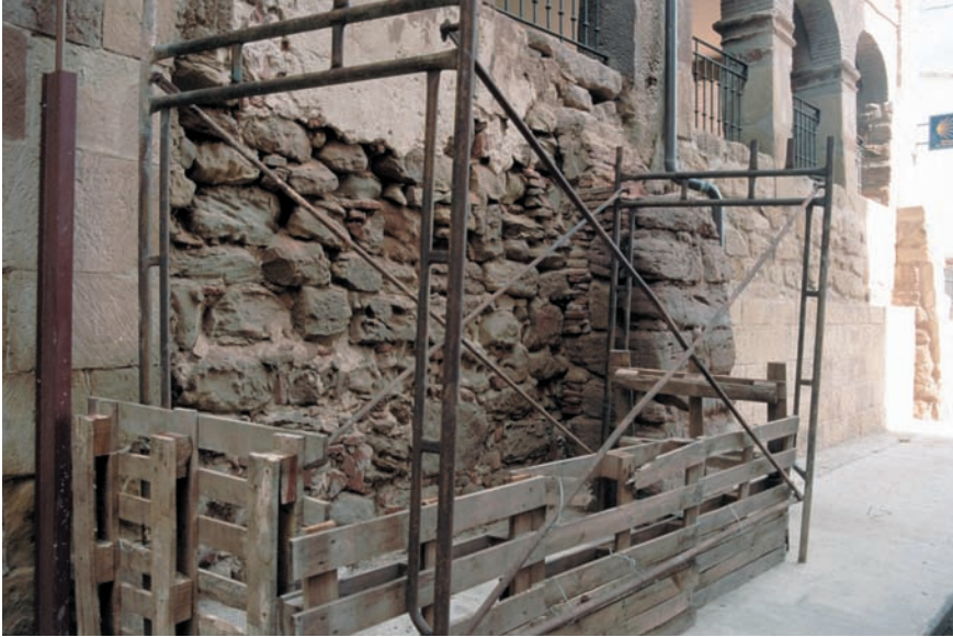
Lám. 1. Detalle de la muralla en la calle Prudencio Muñoz.
