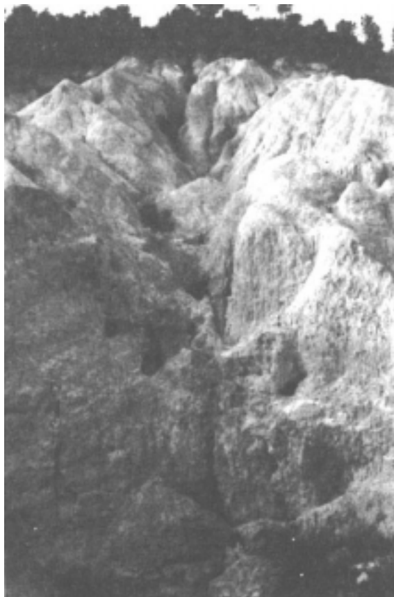
FOTO 2. Detalle del proceso de erosión mecánica que se está desarrollando en la actualidad sobre los materiales margosos que integran la cabecera del Barranco Blanco.
