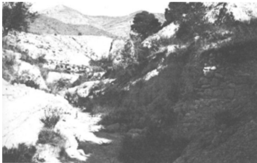
FOTO 6. Restos de la presa de la Casa de la Palmera (a la derecha). Puede observarse el encajamiento del barranco en sus propios aluviones originados a expensas de la instalación de esta infraestructura y la morfología actual de terrazas de cultivo antrópicas sobre el lecho.
