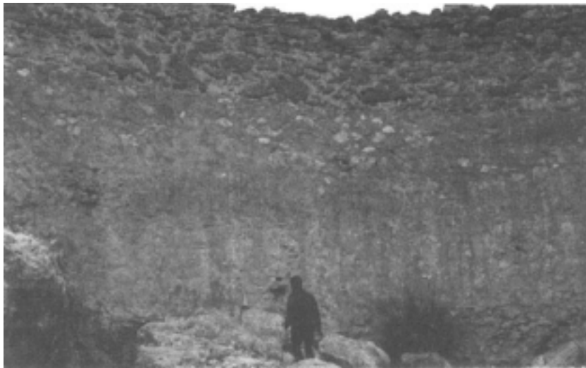
FOTO 3. Vista frontal de la presa de la Murtera.
