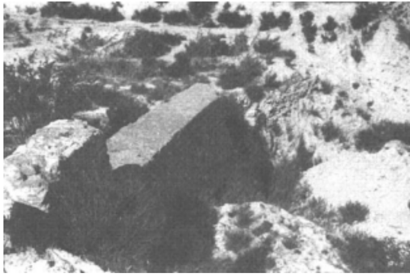
FOTO 7. Estado actual de la presa de la Revuelta, en la que se aprecia el arruinamiento de la obra a causa de una gran avenida del Barranco Blanco.
