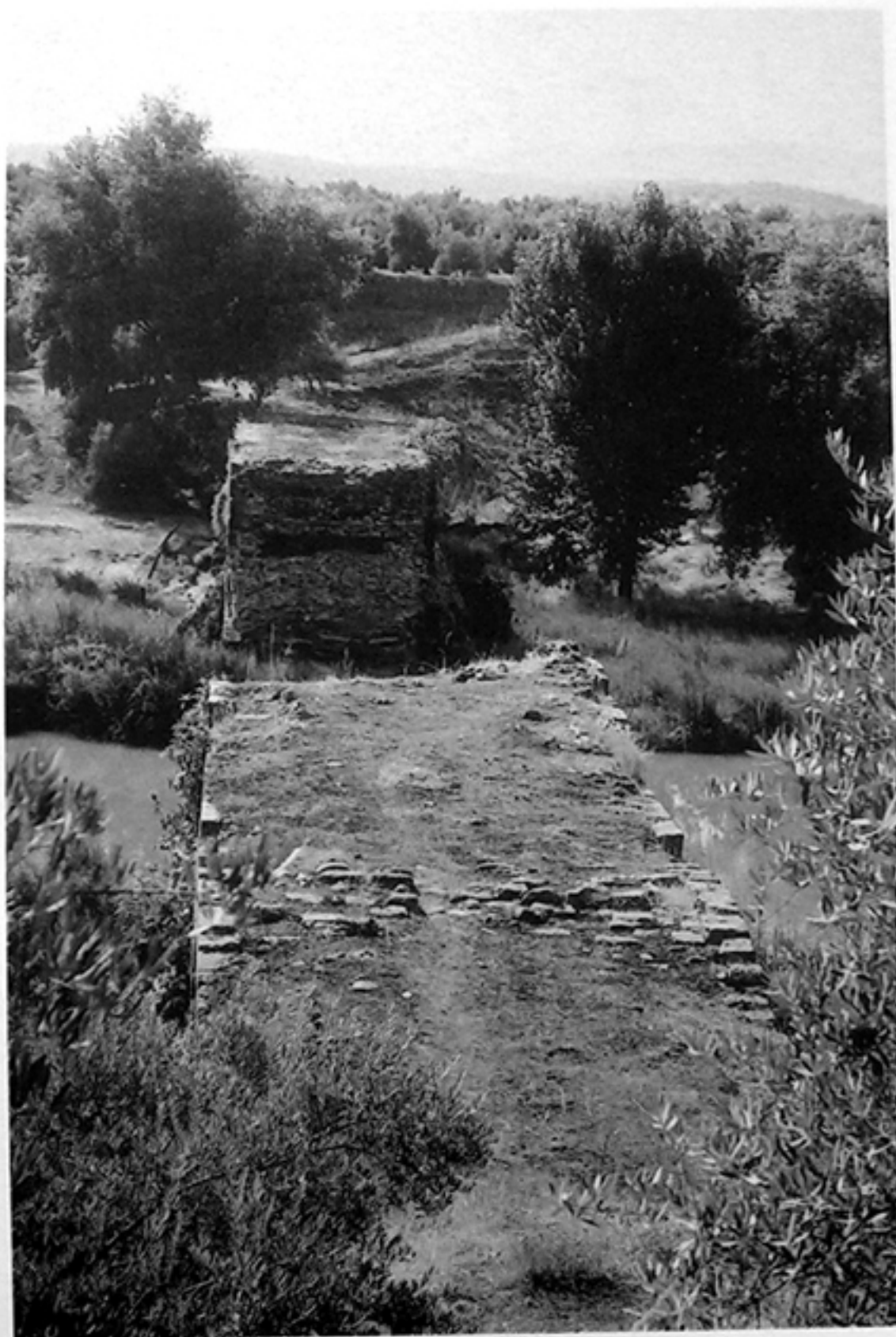
Foto 8.—Puente Quebrada. Vista general.
