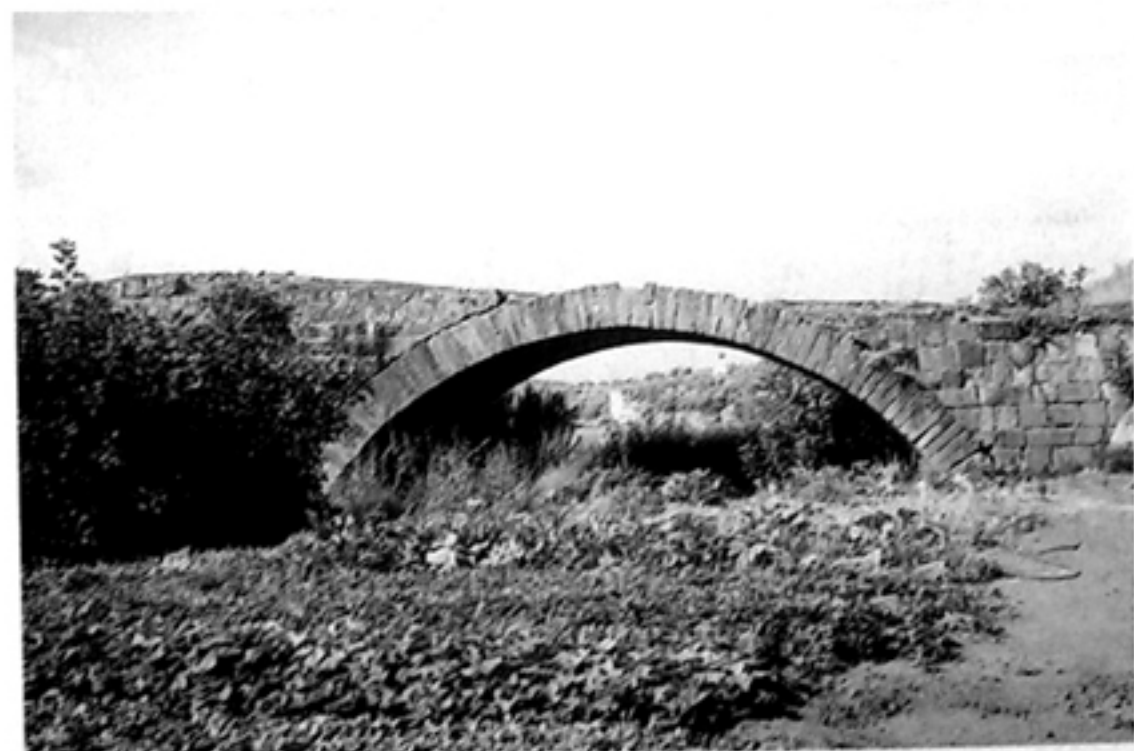
Foto 7. —Puente Quebrada. Arco conservado en la vertiente septentrional, hacia Linares.
