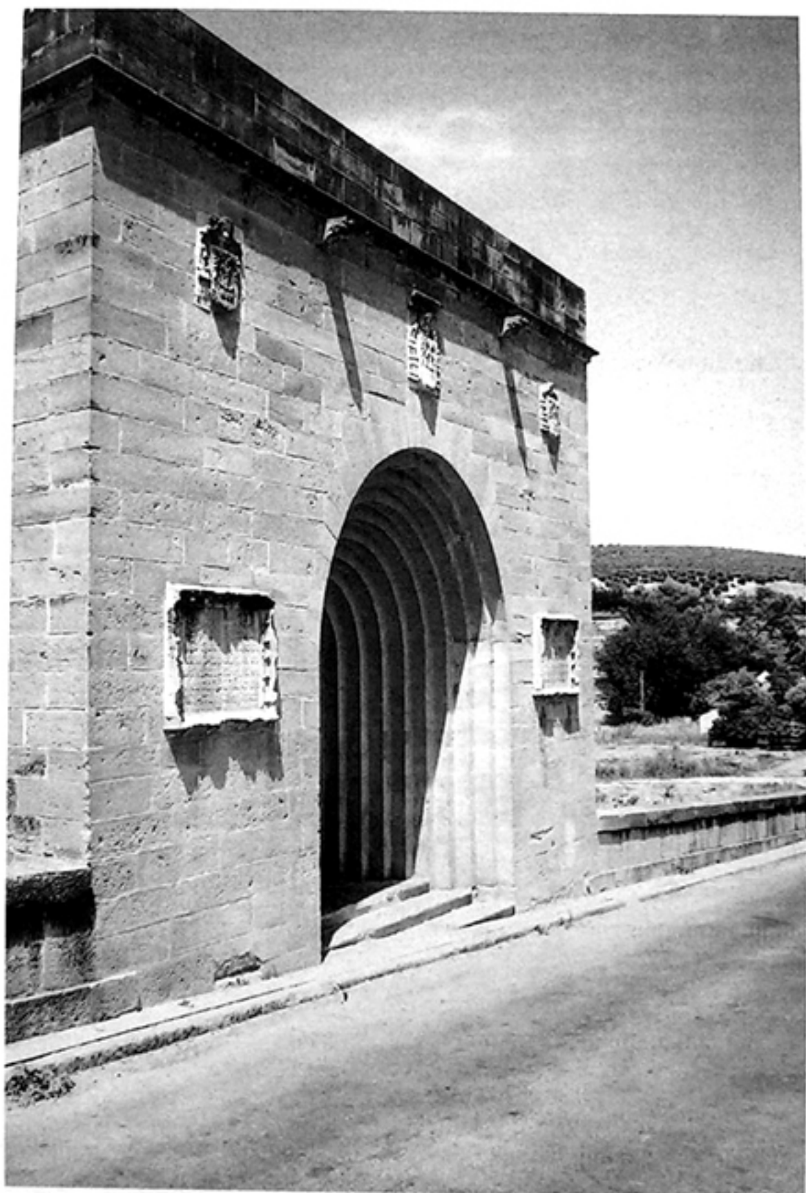
Foto 3.—Portada de la capilla del Puente del Obispo.
