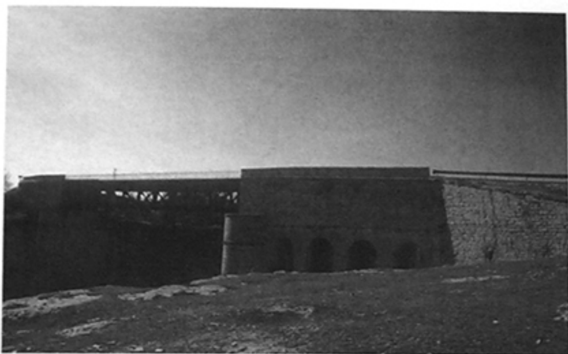
Foto 9. —Puente de Mazuecos, sobre el Guadalquivir. Vista general, desde el flanco oriental.
