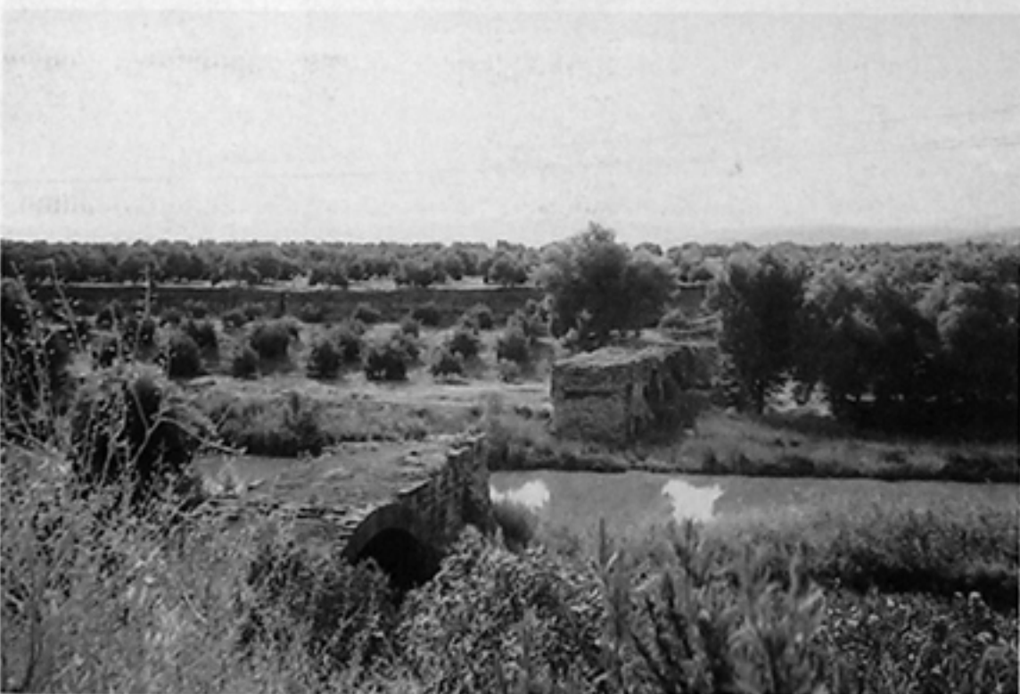
Foto 5. —Vista general de la Puente Quebrada, sobre el río Guadalimar.
