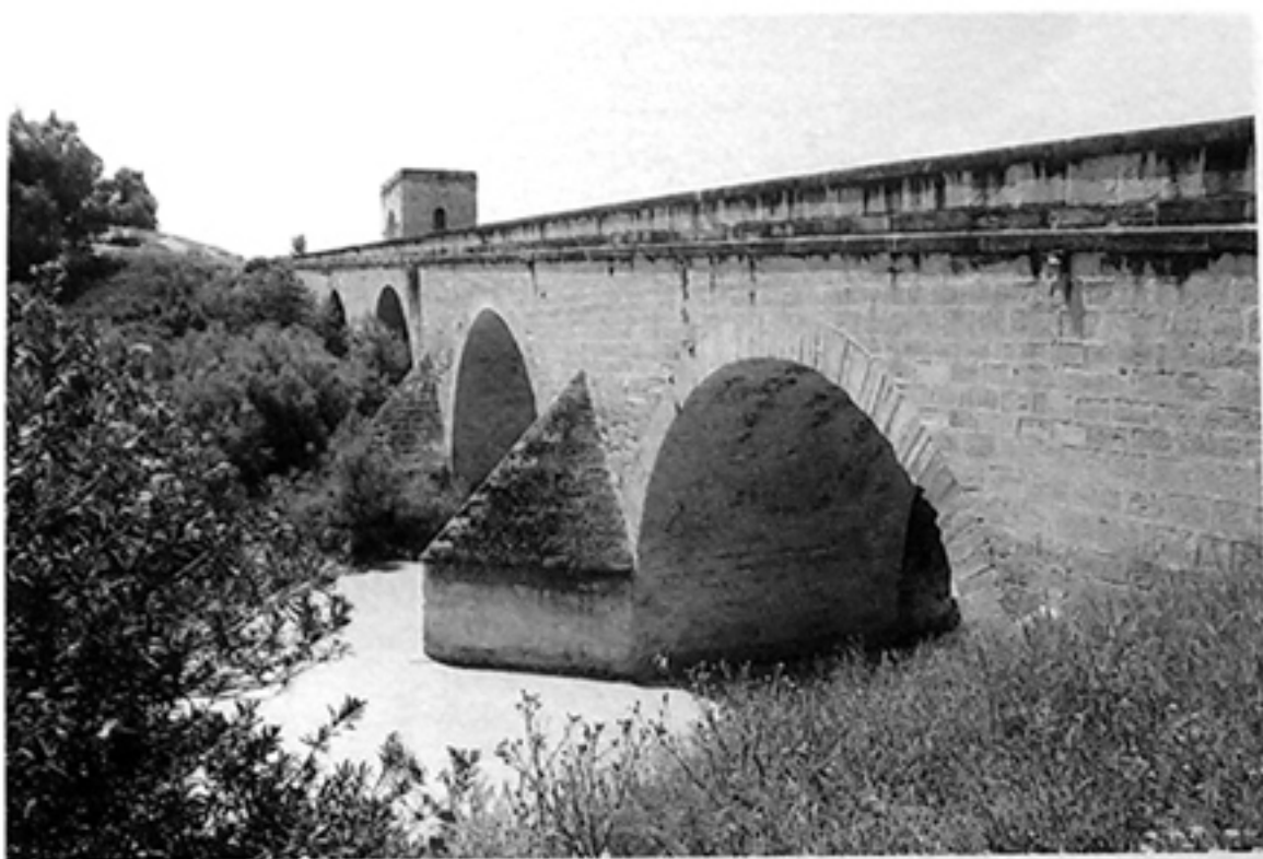
Foto 1. —Vista general del Puente del Obispo, sobre el río Guadalquivir. Flanco oriental.
