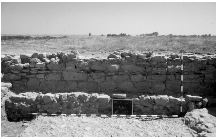
Fig. 8: Muro romano recrecido y 'parcheado' con cantos de río
