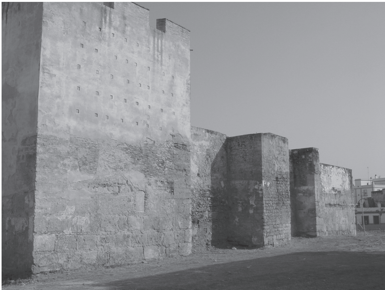
Lámina 1. Vista general del flanco oeste del Castillo de San Romualdo.
