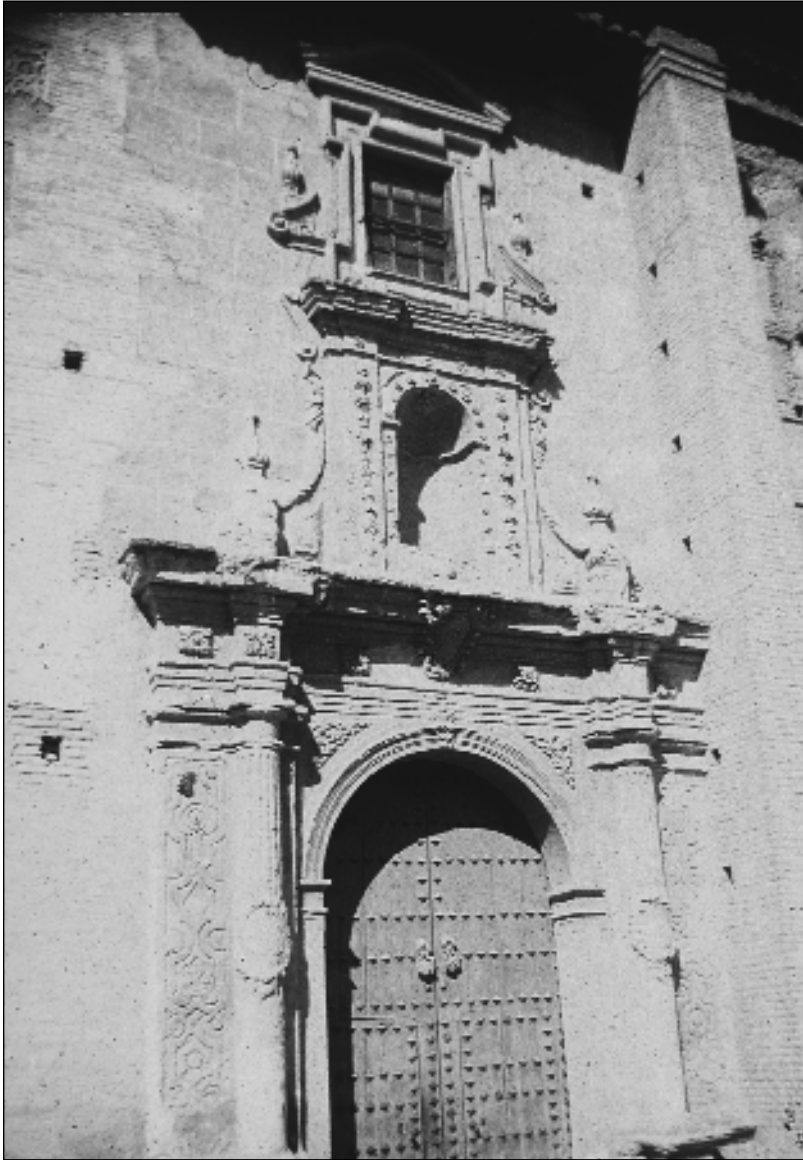
Iglesia Concepción de Guadix (fachada principal).
