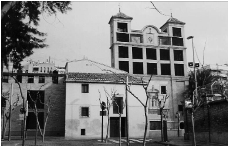
Fig. 2. Vista actual de la Portería del Monasterio de Santa Clara desde su acceso meridional.
