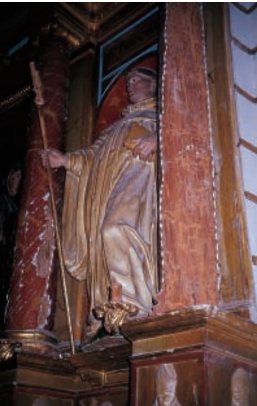
Figura 10. Degradación producida por biodeterioro.
