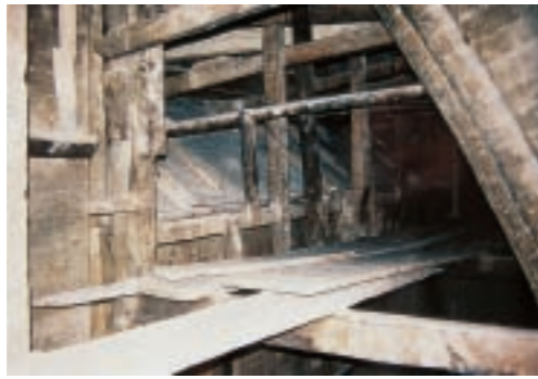
Figura 3. Detalle del sistema estructural de un retablo de principios del siglo XVI.
