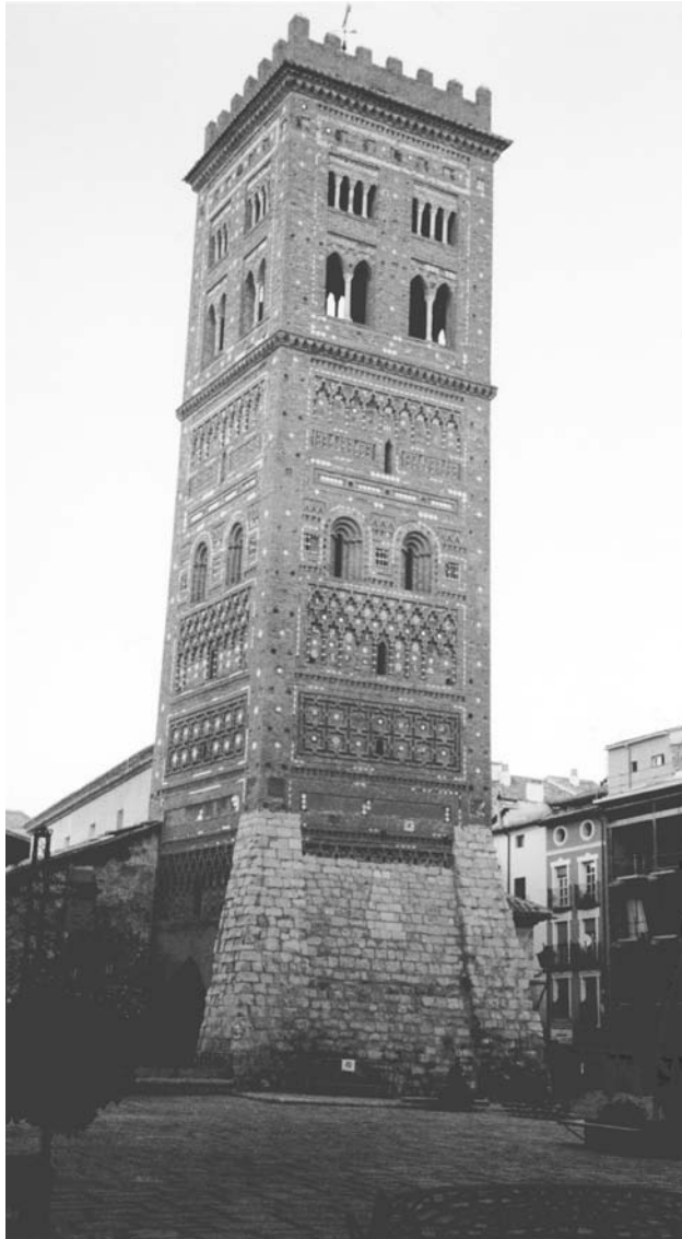
Fig. 1. Teruel, torre de San Martín. Vista general
