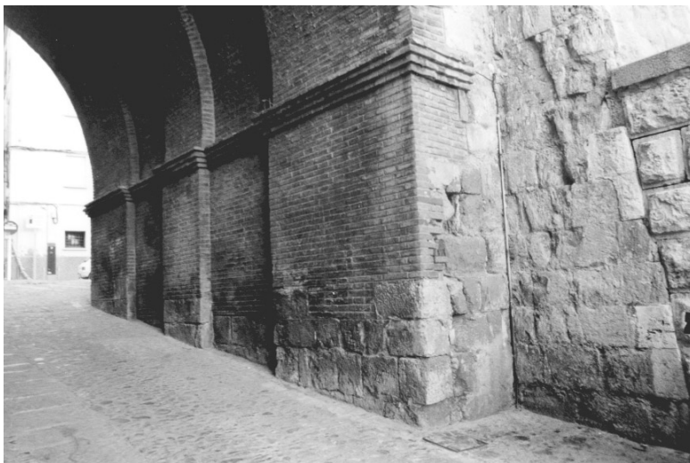
Fig. 2. Teruel, torre de San Martín. El paso interior abovedado en la actualidad.
