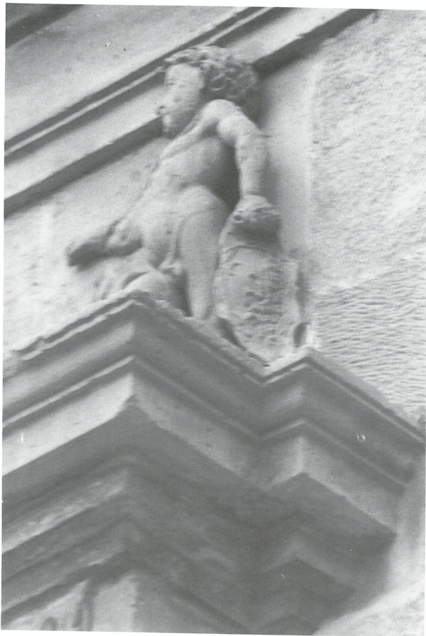
Foto 2.-Palacio del Deán Ortega (sobre dintel puerta principal). Lado derecho.
