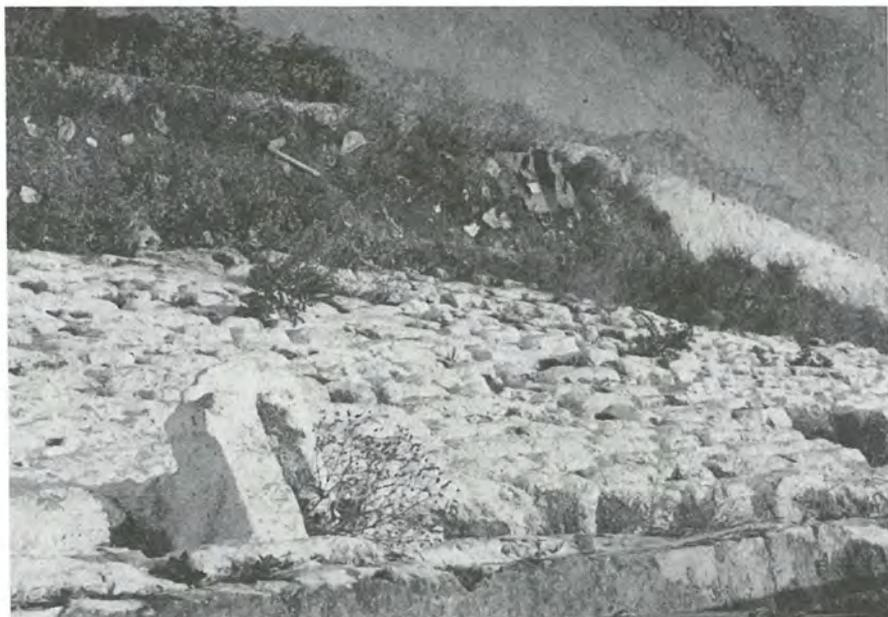
El antemuro del Alcázar de Arjona visto desde su remate superior en el Cementerio de los Santos. Se observa la disposición en talud de esta construcción y, en primer término a la izquierda, restos de un desagüe tallado en una piedra.
