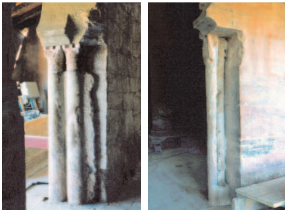
Fig. 18. Aula mozárabe, puerta principal. Jamba oeste, cara interior, y jamba este, cara exterior, mostrando la restauración con madera y estuco (fotos I. Murillo).
