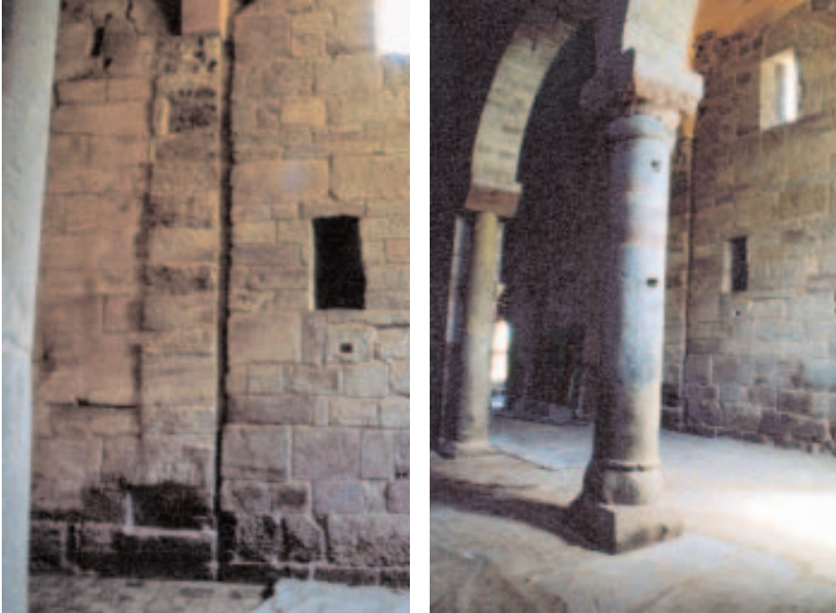
Fig. 19. A) Unión de los muros norte de los tramos mozárabe y protorrománico, con el corte del testero mozárabe; B) Arcada de la ampliación protorrománica.
