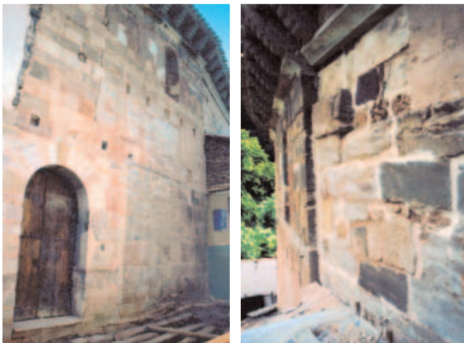
Fig. 21. A) Fachada sur del tramo occidental, protorrománico; B) Detalle de la unión de las fachadas meridionales de las fábricas mozárabe y protorrománica.
