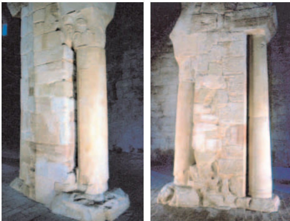
Fig. 20. Pilar de unión de las arcadas mozárabe y protorrománica, con los restos del muro de testero mozárabe, respectivamente lados sur y norte.
