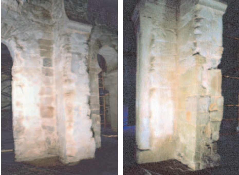
Fig. 13. Lado oriental de las cabeceras norte y sur. Muro premozárabe, con el remate meridional de su estructura, y muros y arco mozárabes y arco de restauración mozárabe cortándole y sobremontándole.
