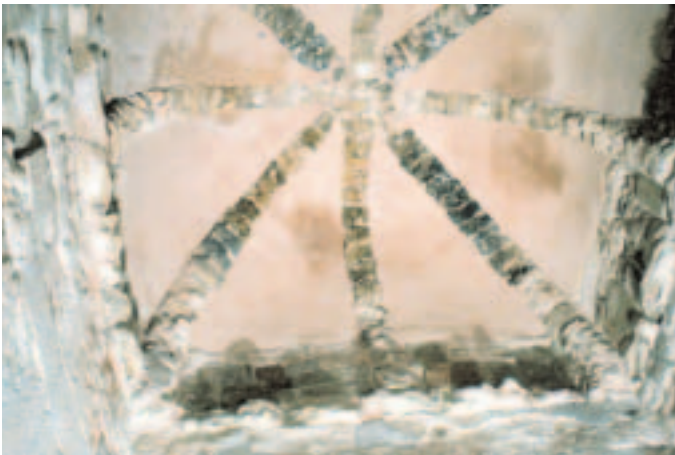
Fig. 12. A) Muro occidental de las habitaciones orientales, remate bajo cubierta (a la derecha de la fig. 9A); B) Bóveda de la cabecera norte.
