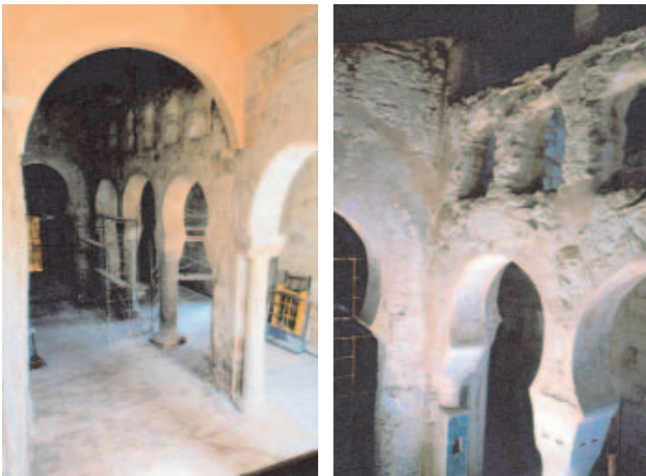
Fig. 15. A) Vista general del edificio mozárabe desde la ampliación protorrrománica; B) Extremo oriental de la arcada mozárabe desde la nave norte. Se observan las huellas del incendio, la restauración posterior y las rozas para apoyar las bóvedas barrocas.
