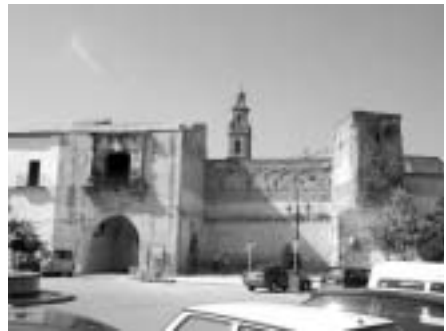
Estado de la Puerta del Sol una vez demolido el edificio/cochera adosado a ella. Foto: Rafa Nieto.
