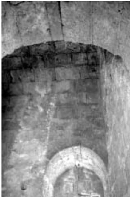
Castillo de Priego. Interior de la Torre 2. Ejemplo de la recuperación de espacios medievales, parasitados o desvirtuados por obras posteriores que han sido desmanteladas durante la intervención.
