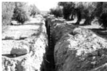
Lám. II. Una de las zanjas abiertas para la instalación del riego.
