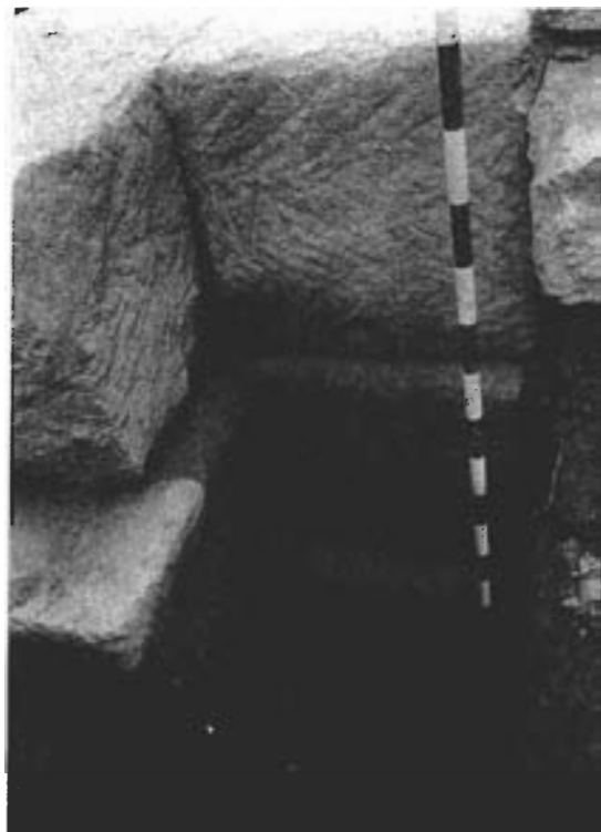
Fig. 12.- Detalle de la edificación con los sillares grabados, plaza de Lizana.
