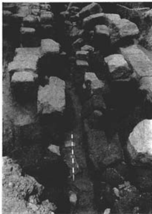
Fig. 11.- Detalle de la canalización, plaza de Lizana.
