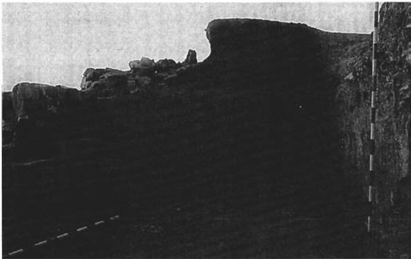
Lám. V. Interior de la torre. Se aprecia el muro con la base de piedra y la elevación de tapial. La mancha oscura del suelo corresponde a los restos del entramado carbonizado.
