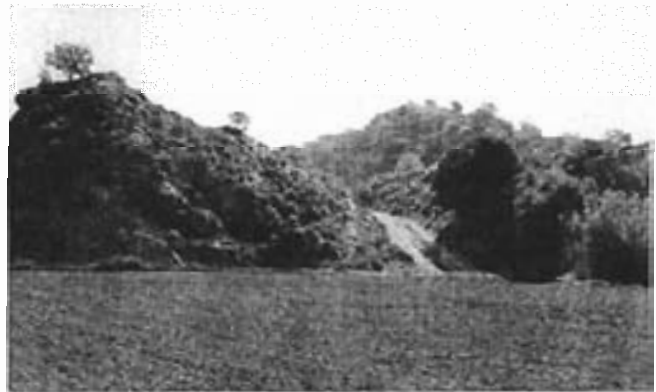
Foto 22. Vista de la Alcantarilla desde el oeste. En el extremo derecho de la fotografía puede observarse el trazado del canal y el camino, que han alterado profundamente este enclave.
