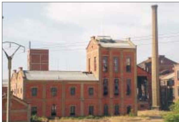
FIG. 3. Estado actual de la azucarera «Santa Elvira» de León.
