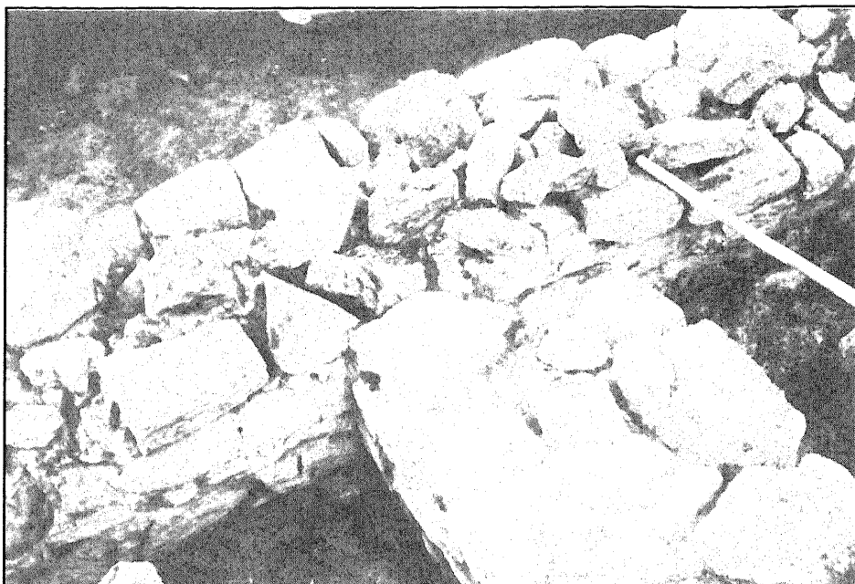
Sector Meridional, detalle de la confluencia del muro de división
