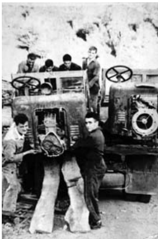
Unha máquina de pequenas dimensións servía para conducir o mineral polo túnel do Bouloso (C.F.)
