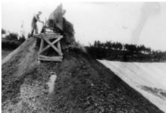
Os carbonatos eran peneirados antes de introducirse nos fornos (C.F.)
