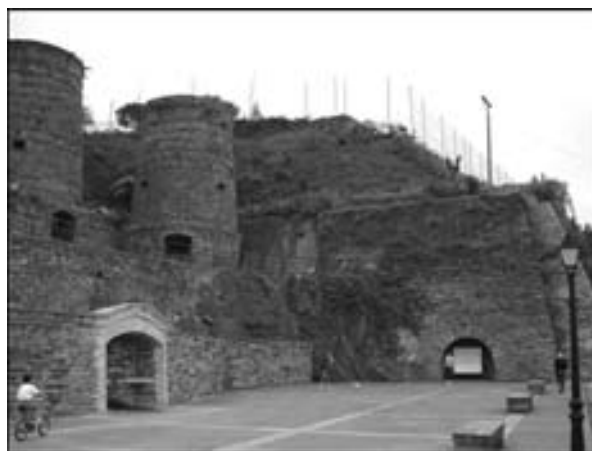
Depósito para o embarque de mineral mediante a introducción inferior de vagóns. Enriba, a inicios do século XX (Hernández Sampelayo, 1931, t2). Abaixo restos visibles na actualidade.
