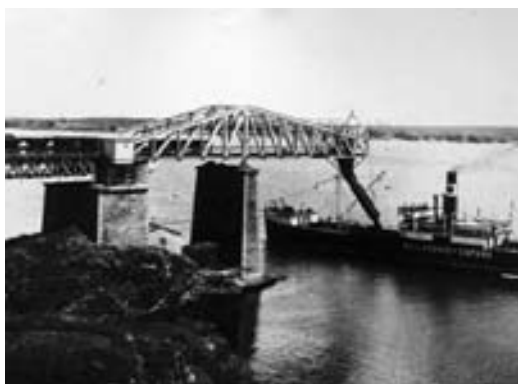
Perspectivas diferentes pero complementarias do deseño e modo de funcionamento do cargadeiro de mineral construído pola Sociedad Minera Villaodrid en Porto Estreito, Ribadeo (C.F.)
