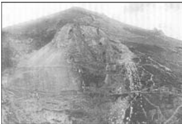
Vista do sistema de galerías superpostas na mina Consuelo, no que se aprecia a situación do mineral delimitada por cuarcitas (Hernández Sampelayo, 1931, t2).
