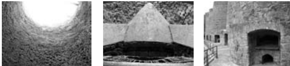
Reconstrucción do proceso de calcinación de carbonato a partir da arquitectura dun forno da época. De esquerda a dereita, boca dos fornos, cono de distribución e porta de saída.
