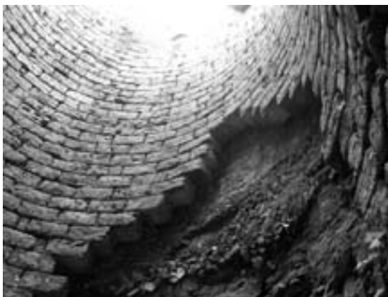
Estratigrafía interior do forno do Boulloso, no que resulta visible o método de construción e o ladrillo procedente da fábrica de Sargadelos.
