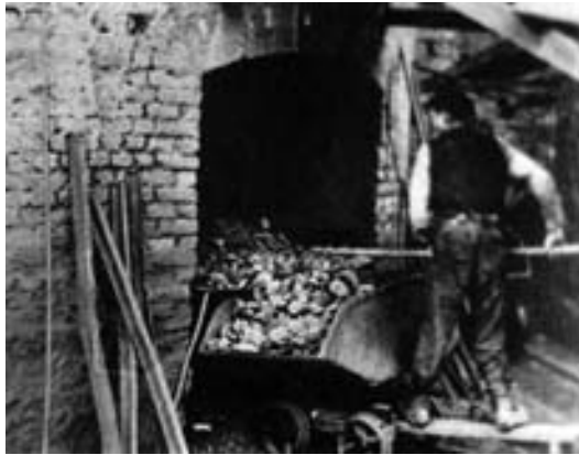
Imaxe retrospectiva dun traballador baleirando o mineral calcinado do forno (C.F.).
