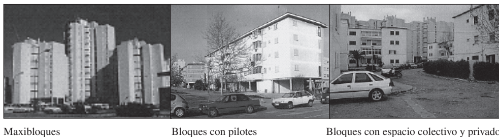
Figura 11. Tipologías de bloques de edificios en el Polígono de Llevant.
