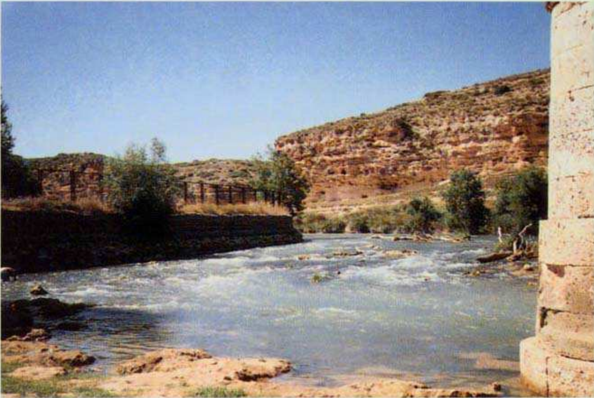
Estación J-4: Puente carretera de Motilleja.
