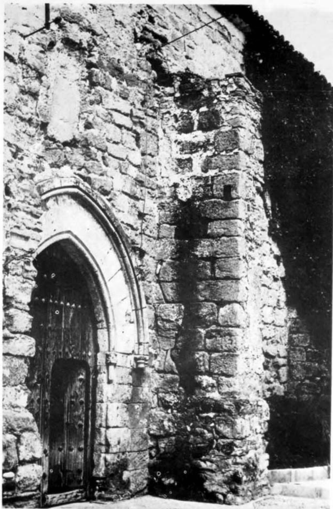
Puerta de ingreso.
