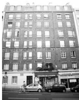
Figura 13. Edificio de viviendas para obreros erigido en 1888 por la Société Philanthropique en el número 45 de la calle Jeanne d'Arc de Paris (arqto.:Chabrol)[DUMONT,1991]. Foto: M. Castrillo, 1999
