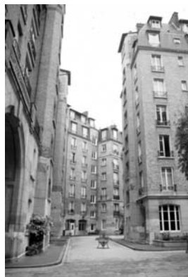
Figura 15. Vista de uno de los patios abiertos de la manzana edificada por la Foundation Rothschilden la calle Prague de Paris siendo el proyecto ganador del concurso convocado en 1904 (arqto.:A.A.Rey)[DUMONT,1991]. Foto: M. Castrillo
