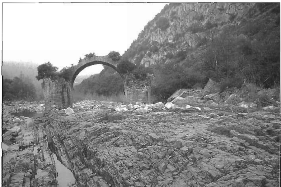
Puente de Gubín: vista del arco, aguas arriba. asentado sobre roca
