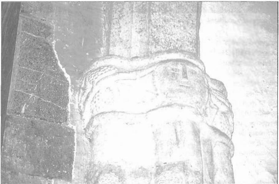
Pendueles. Detalle de los apoyos interiores
