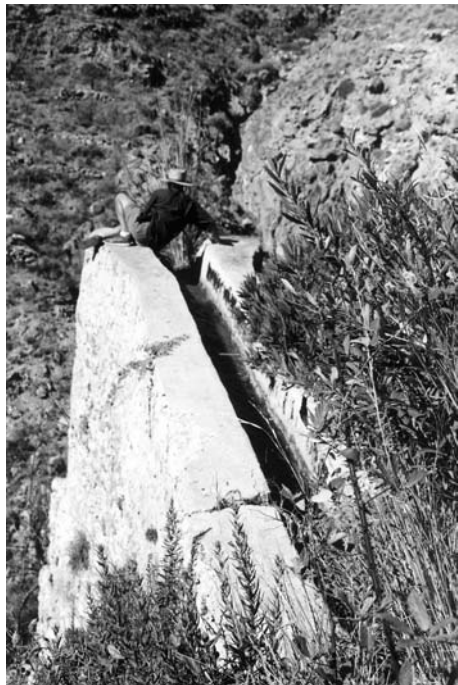
5. El canal o caz que va al cubo del Molino 20.
