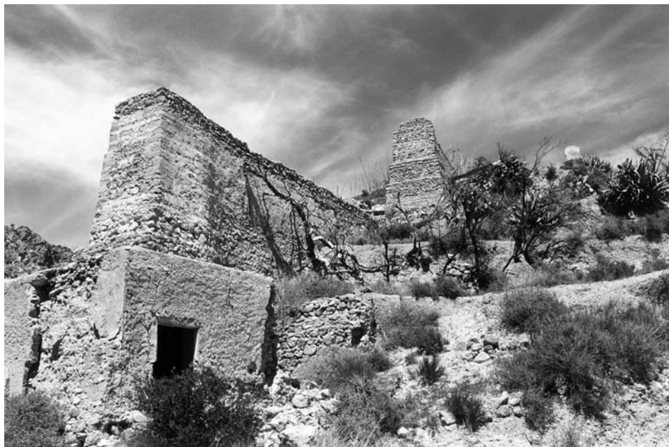
7. Las estructuras de los Molinos 12 y 13.
