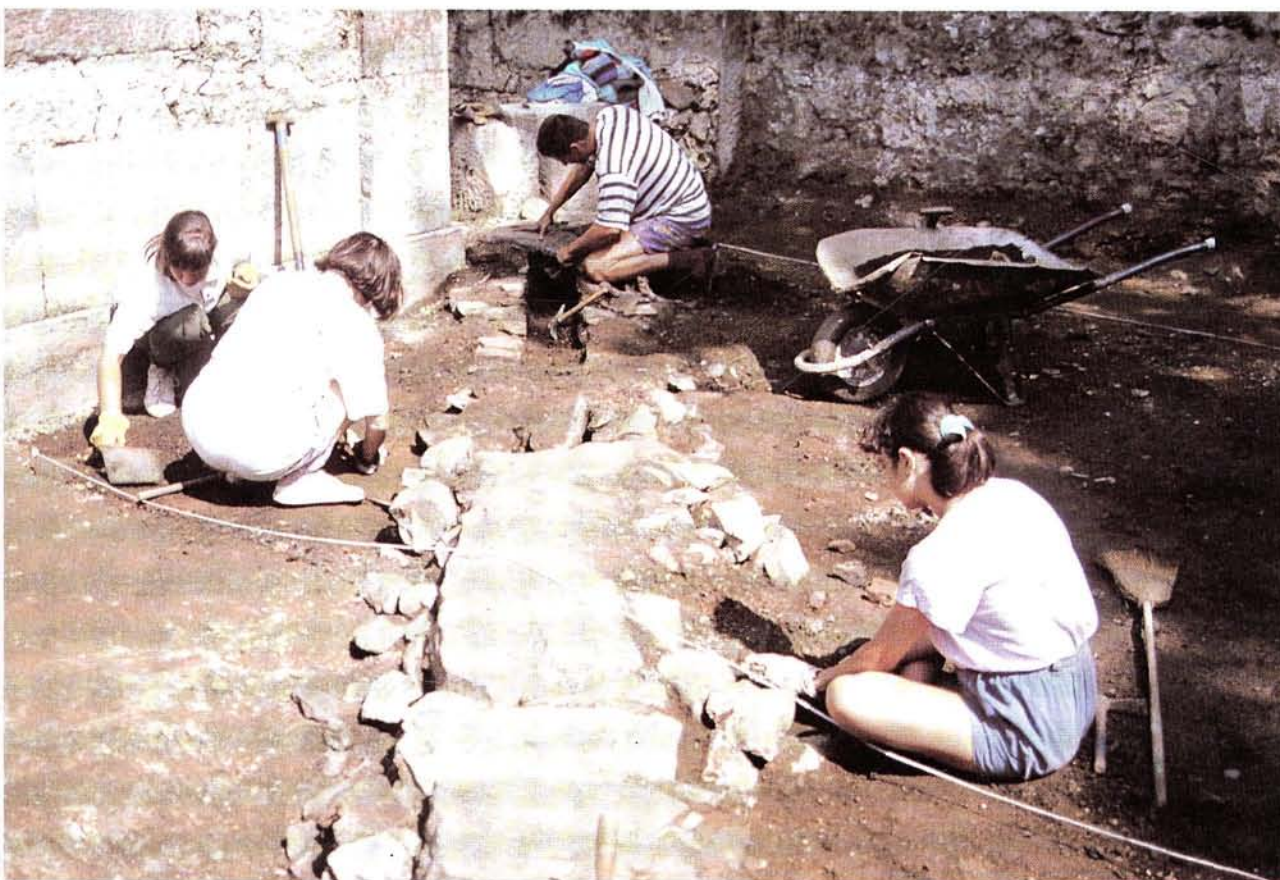
Foto 2 Canalización del acceso de Aézcoa.
