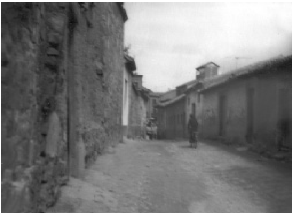
2. Muros perimetrales de Santo Domingo en la Ronda Madrid (1970). Foto José Ignacio Regueras Grande.
