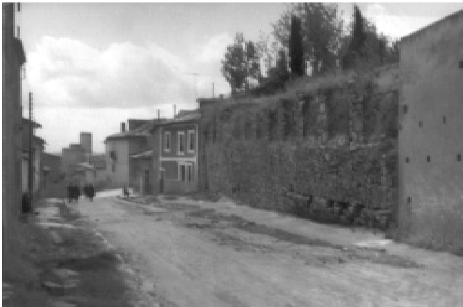
1. Muros perimetrales de Santo Domingo en la Ronda Madrid (1970). Foto José Ignacio Regueras Grande.
