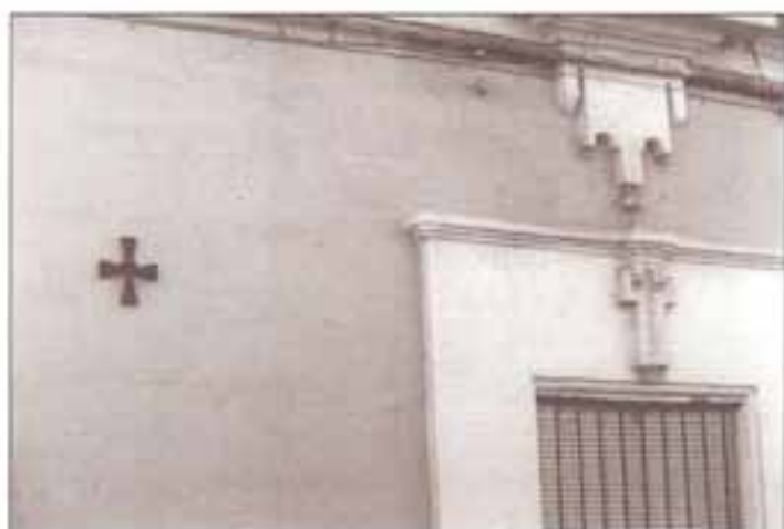
Cruces en fachada y dintel. Calle Cruces, 67
