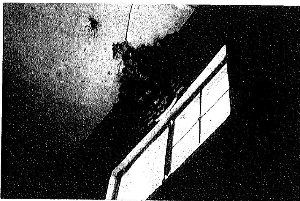
Figura 9. Yasería del frente de la bóveda de la escalera.
