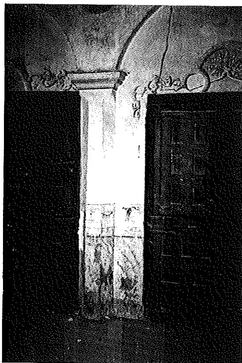
Figura 10. Sala principal, pared que da a la escalera.
