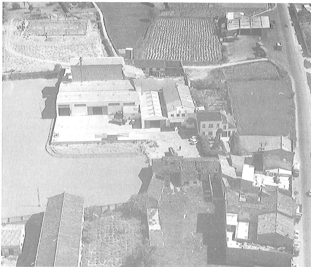
Panorámica de la vieja fábrica de piensos de UVESA situada en la travesía de la carretera de Zaragoza.
