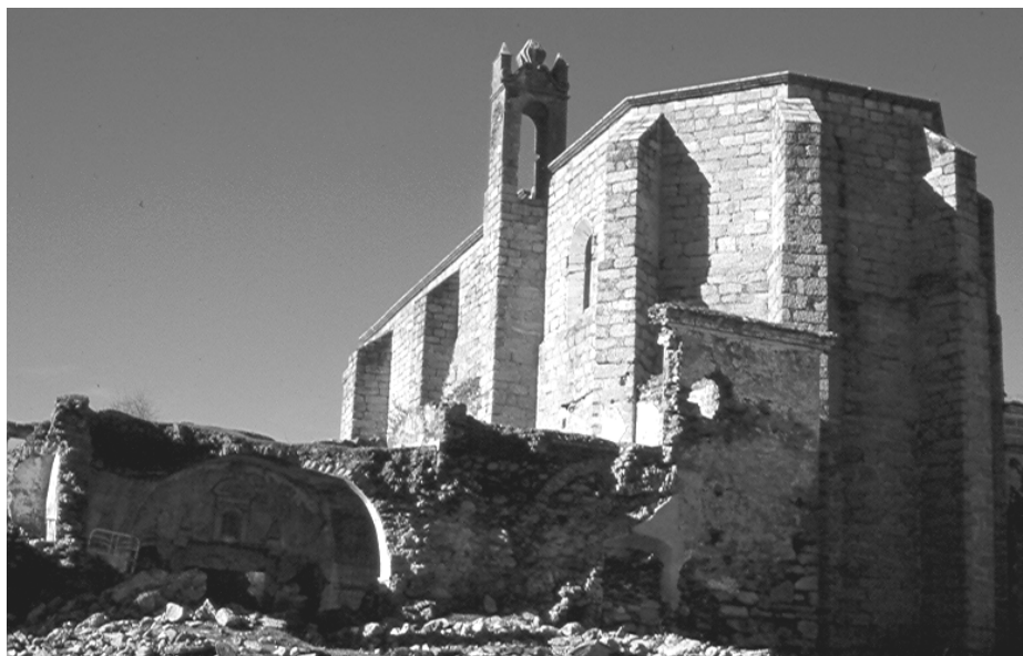
Figura 6. Convento de San Antonio de Garrovillas (Cáceres). Exterior.
