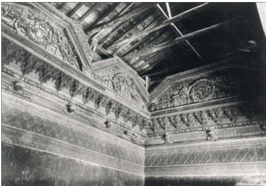
■ Fig. 5. Palacio de los condes de Miranda. Artesonado de la escalera a principios de siglo. AMB. FO-2.886.
