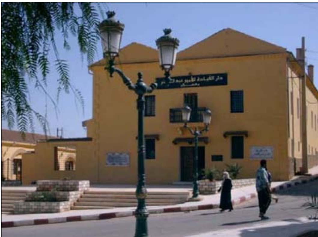
■ Fig. 2. Quartier général de l'émir à Mascara, après restauration (M. Bouziane).
