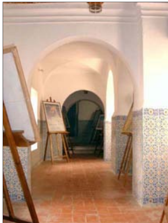
■ Fig. 6. Quartier Général. Le péristyle après sa restauration (M. Bouziane).
