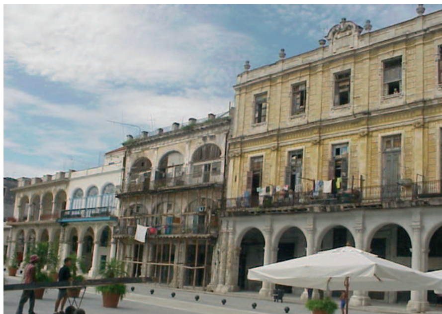
FIGURA 10: EN PRIMER PLANO, A LA DERECHA, LA CASA DE LOS CONDES DE CAÑONGO, EN FASE INICIAL DE RESTAURACIÓN.
