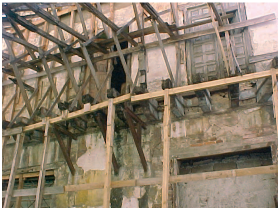
FIGURA 8: CASA DE PRATS PUIG EN PROCESO DE RESTAURACIÓN.
