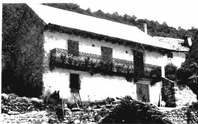
Número 19.—Fachada principal con galería de "Ezpelondokua" - 1969
